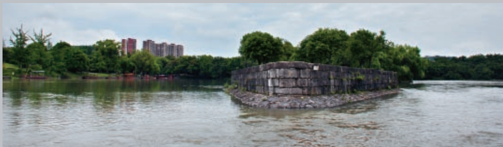
灵渠位于广西兴安县境内，主体包括铤堤、南北渠、秦堤、陡等，于公元前214年凿成通航。其通三江、贯五岭，有效沟通了南北水路，至今仍然发挥着作用。
